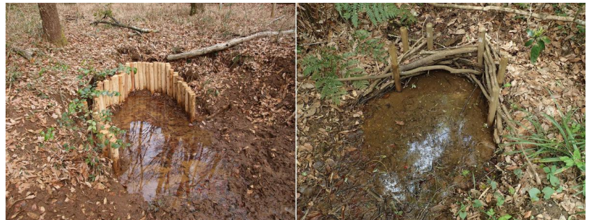
図 5.12: 土留杭（左図）としがら柵（右図）。
