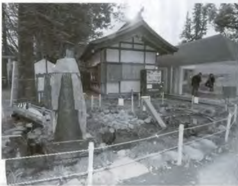
池の様子(完成前)
